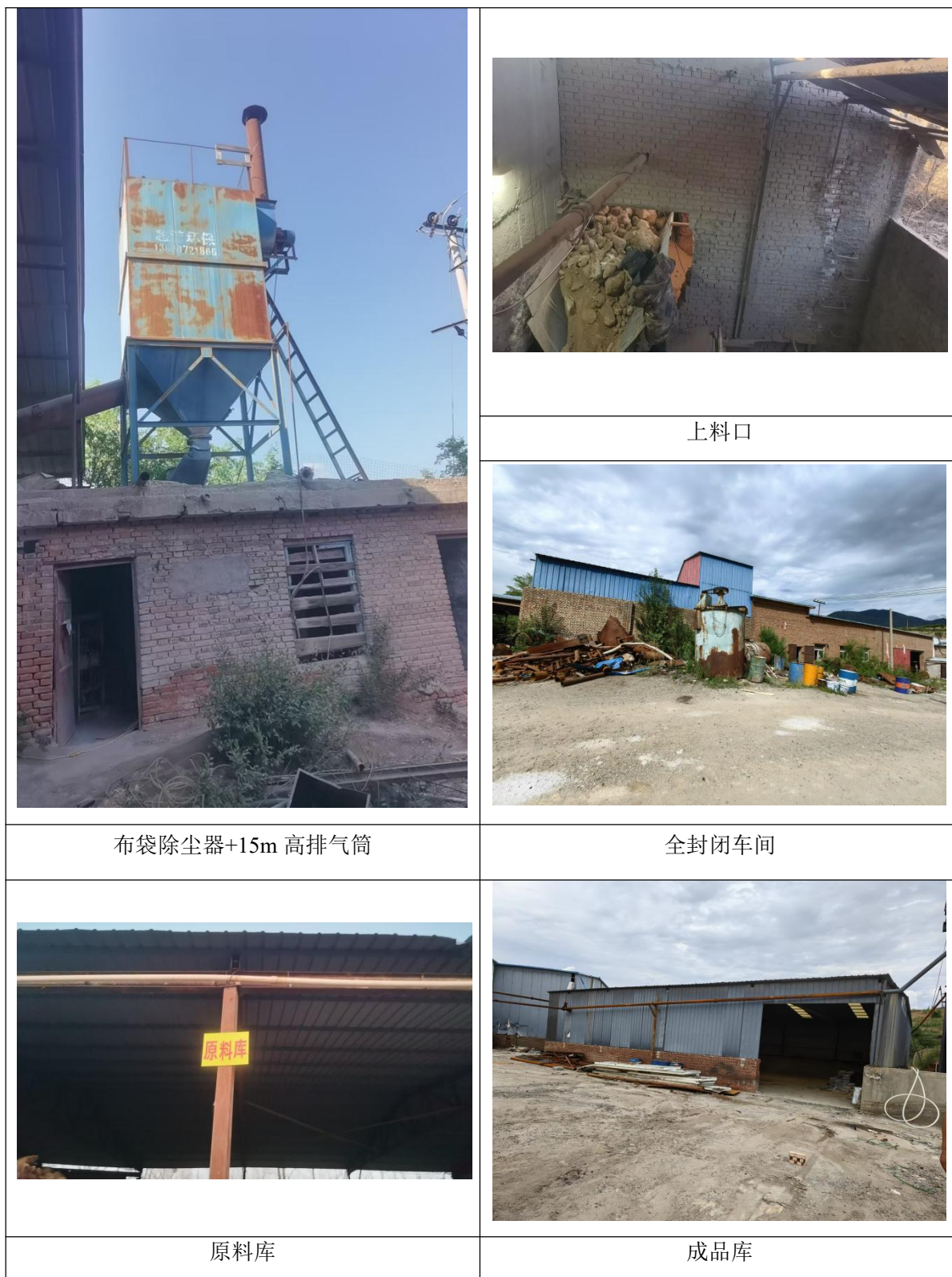
图 3-1 项目废气污染物处理措施现场照片
